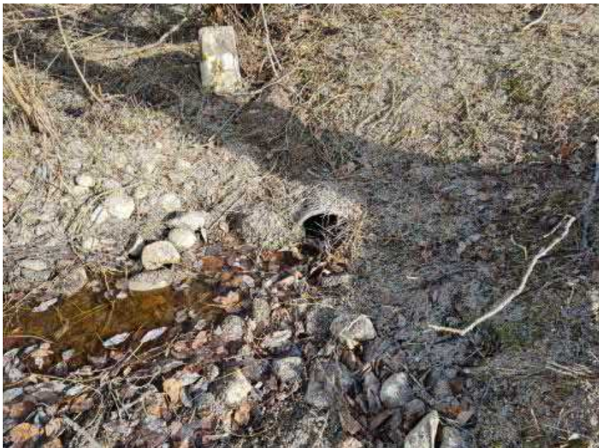
Kuva 4. Liittymiskohta Kuukantien hulevesiviemäriin. Kuva: Janne Koskenkorva.
