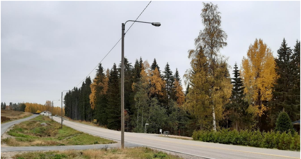
Kuva 7. Kuva Multiantien varresta Uuraisten keskustaan suuntaan. Rantatien liittymä kääntyy kuvassa oikealle. Kevyenliikenteenväylältä tulee pisto Multiantien varteen noin 15 metriä Rantatien risteyksestä länteen.
