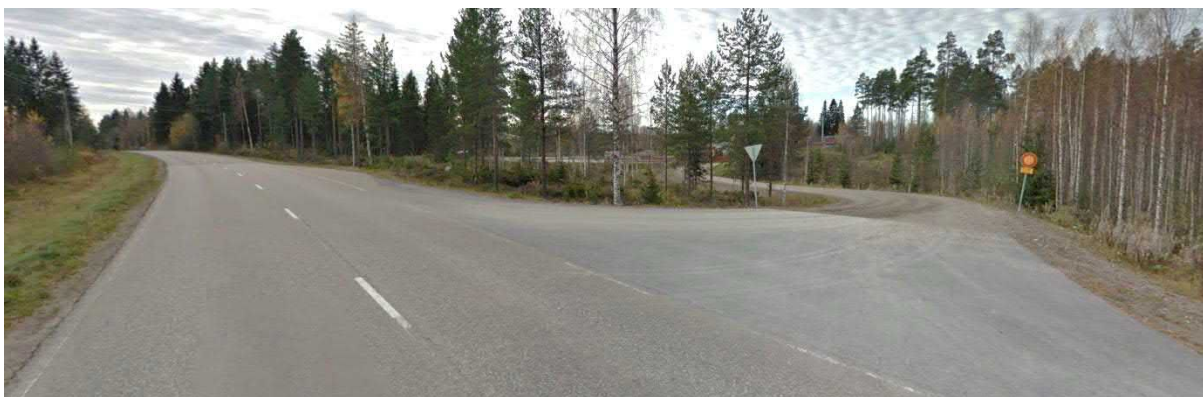
Kuva 6: Haukimäentien liittymä (Kuva: ©Google)
